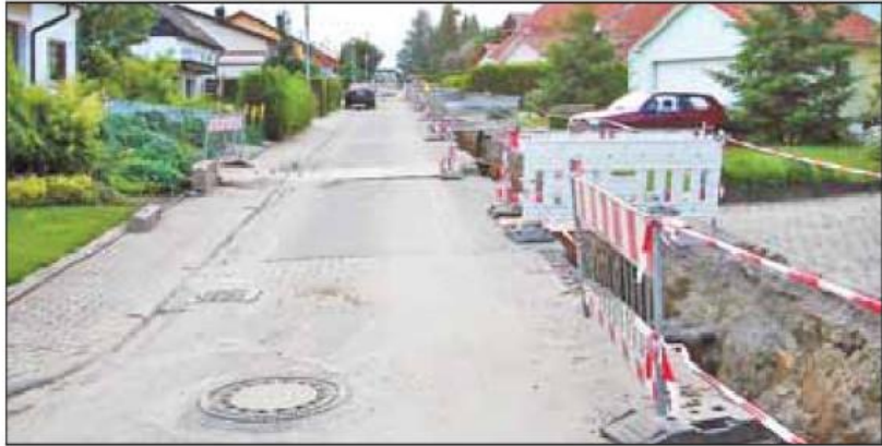
In vollem Gange sind in Großeicholzheim die Bauarbeiten zur Schaffung eines Nahwärmenetzes. Insgesamt 8 000 Meter Leitungen werden verlegt. Foto: L. Merkle
